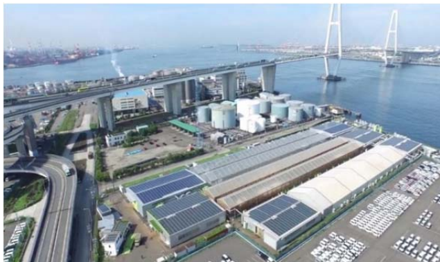
写真 2-1 「バイオプラザなごや」の外観
